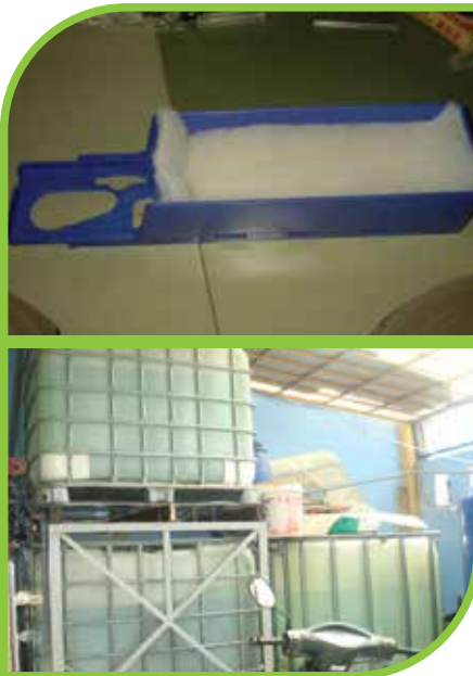
Hình 3: Hệ thống lọc
