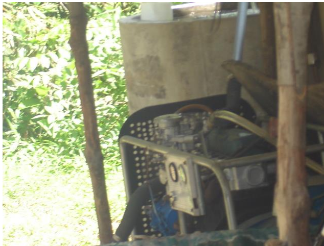
Tận dụng khí thải từ hệ thống biogas cho máy phát điện
