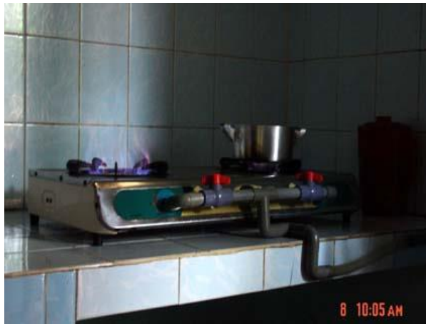
Tận dụng khí thải từ hệ thống biogas cho đun nấu
