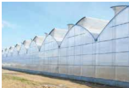
Hình 5. Kiểu nhà màng hai mái đóng mở kiểu cánh bướm
